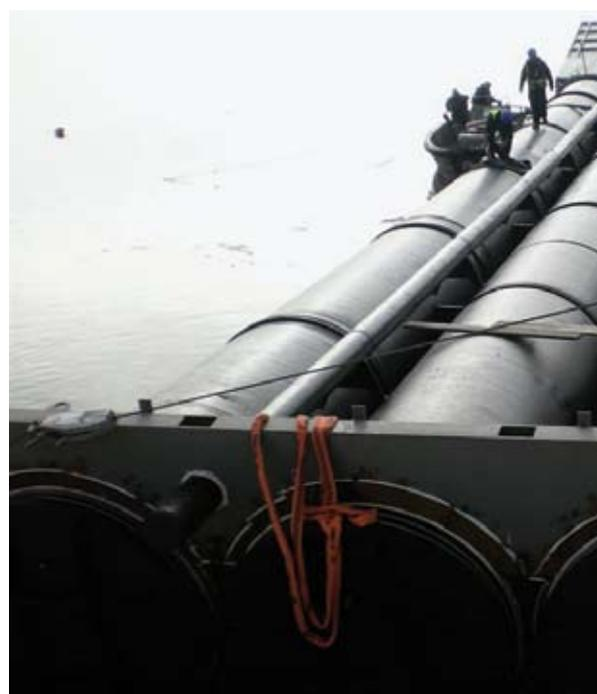
**Todas las uniones fueron probadas en obra a 7 bares y 4 bares (Tuberías de agua fría/caliente).**
